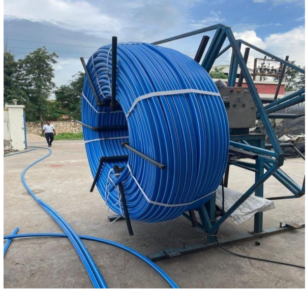
Fig-5, PLHDPE Pipe Uncoiling
