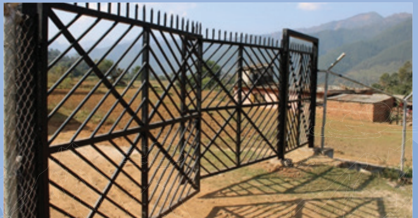
नुवाकोटको बेलकोटगढीस्थित रातमाटे सबस्टेशन निर्माणस्थलको २०.२७ हेक्टर जग्गामा निर्माण सम्पन्न गरिएको तारबार।
