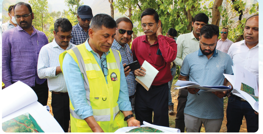
एमसीसी नेपाल कम्प्याक्ट अन्तर्गत सबस्टेशन निर्माणका लागि इच्छुक र सम्भाव्य निर्माण व्यवसायीहरू सबस्टेशन निर्माणस्थलमा।
