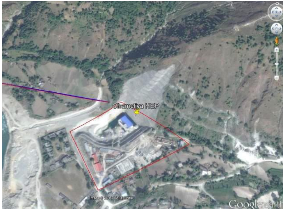
Figure 3.45 Existing Balanch Substation – Latitude 29°41'06.5"N Longitude 80°39'00.5"E
