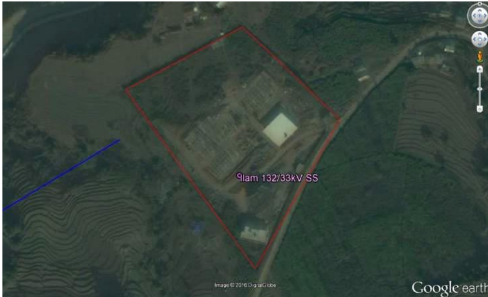
Figure 3.43 Existing Ilam Substation – Latitude 26°52'36.3"N Longitude 87°55'32.7"E
